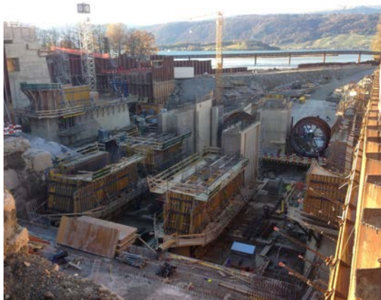
Blick auf die Kraftwerksbaustelle Hagneck. Foto: zvg
